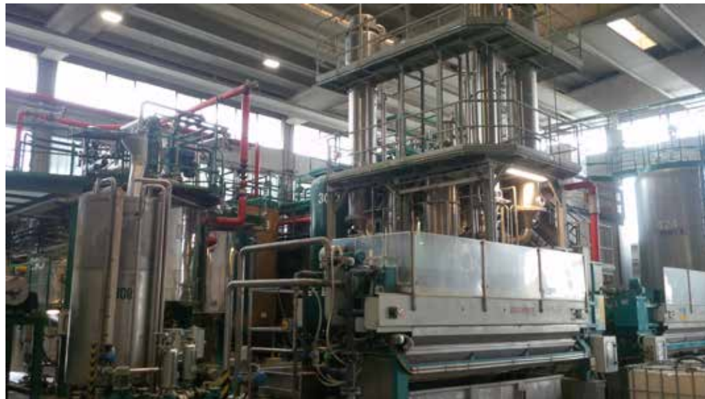
Figura 2 Impianto di idrolisi enzimatica (processo FCEH®)
